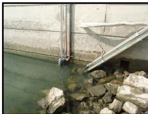
Figure 18 : pompe hydraulique et rampe hors de l'eau en rive gauche (MRM)
